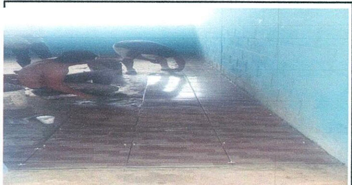
Foto 4: BASE DE COLOCACION DE PISO EN EL AULA
