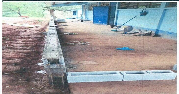
Foto 2: VISTA DEL CORREDOR
