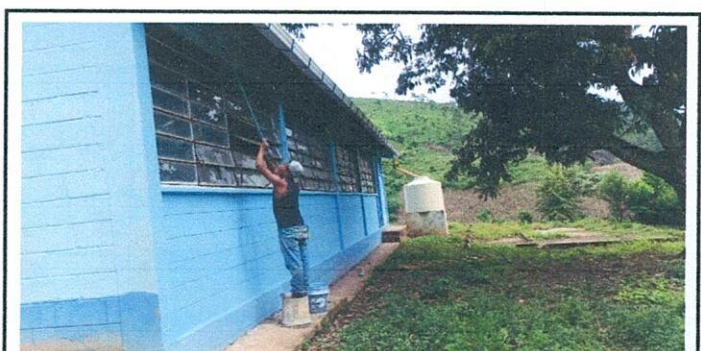
Foto 6: PINTURA DE PAREDES ATRÁS DE LAS AULAS
